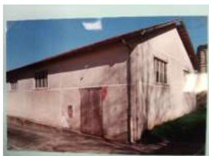
Le bâtiment ... avant travaux
